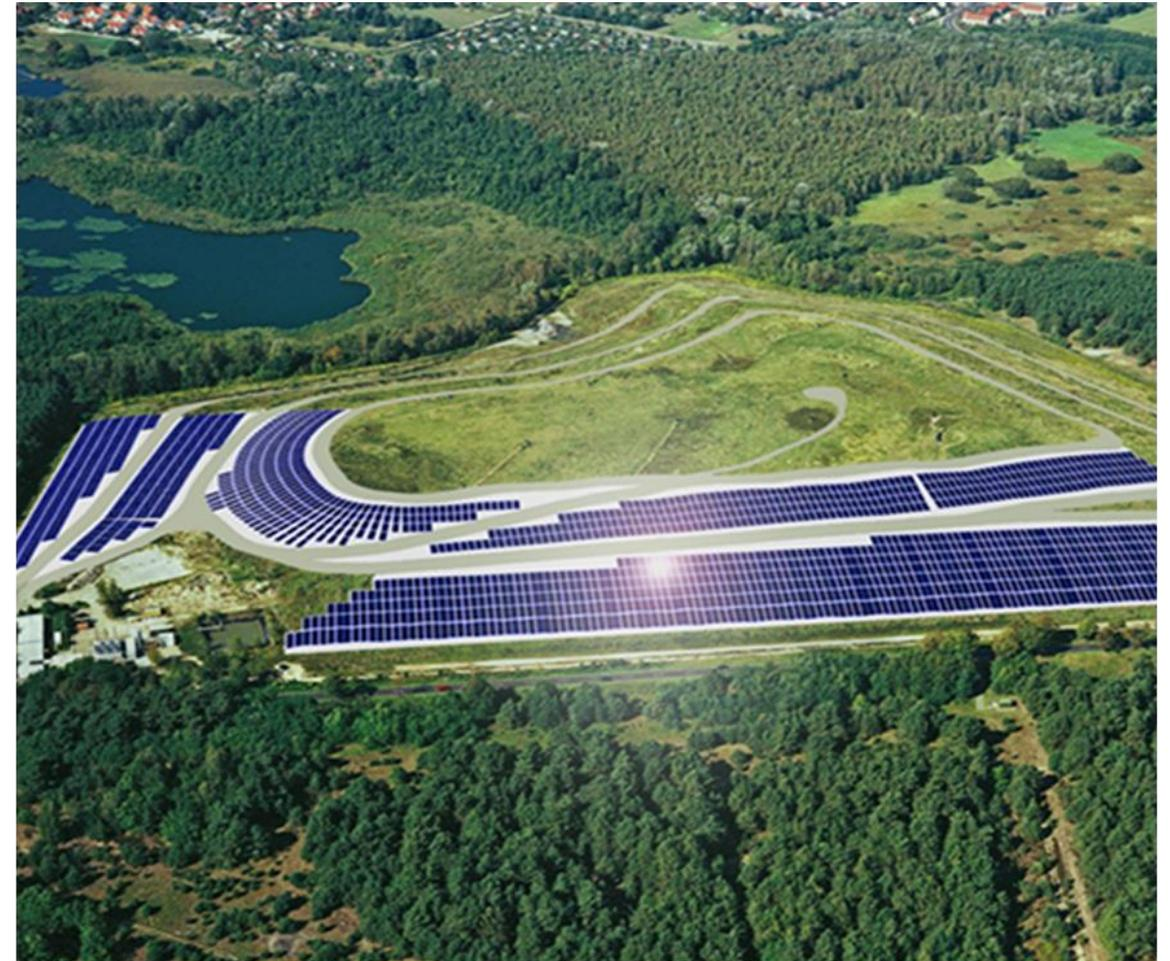
Fotomontage einer 3,44 MW PV-Anlage auf der Deponie Wernsdorf
